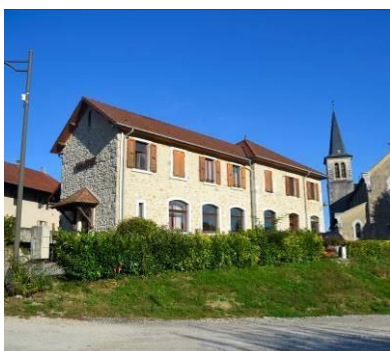
2 pans, 2 pans avec demi-croupes ou 4 pans tuiles rouge brun absence d'ouvertures
