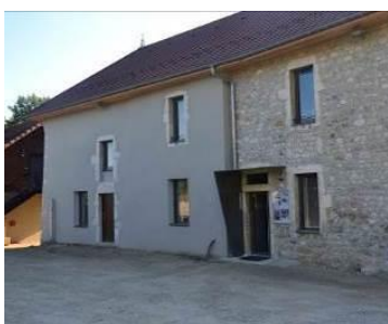
enduit fin et pierre apparente
